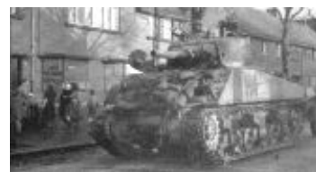
Tanks en andere vechtmachines, bemand met negers, daverden langs de geblindeerde huizen van de Kaldenkerkerweg te Venlo
